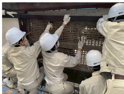
川会所の土壁をはがす作業に取り組む様子
